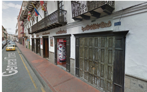
Fig 100. Acera deslizante. Cortesía Google, 2015.
