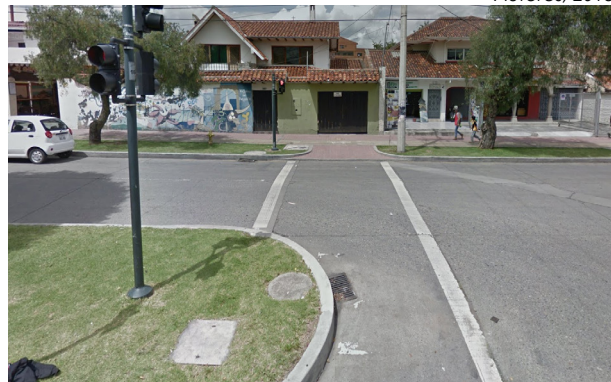
Fig 28. Rampa alineada con el cruce. Cortesía de Google, 2015.
