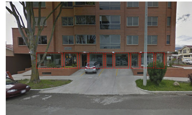
Fig 75. Ventanas en edificación sin cerramiento. Cortesía Google, 2015
