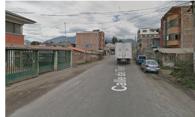
Fig 161. Mantenimiento general malo. Cortesía Google, 2015.
