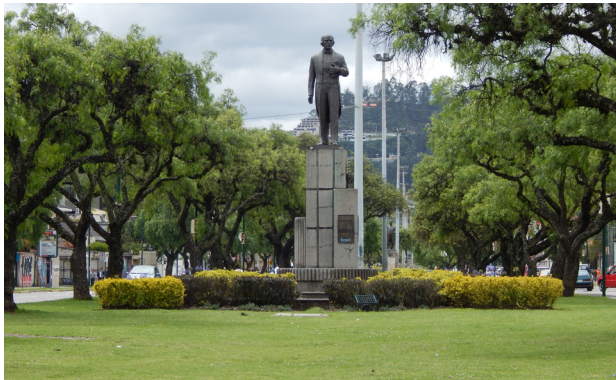
Fig 158. Mantenimiento general Muy bueno. Autores, 2018.
