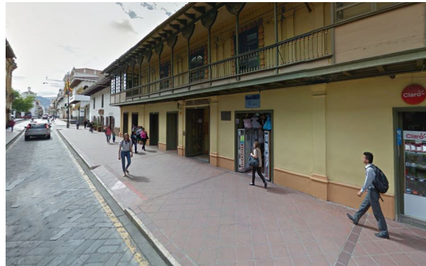
Fig 113. Volados de edificios. Cortesía Google, 2015.
