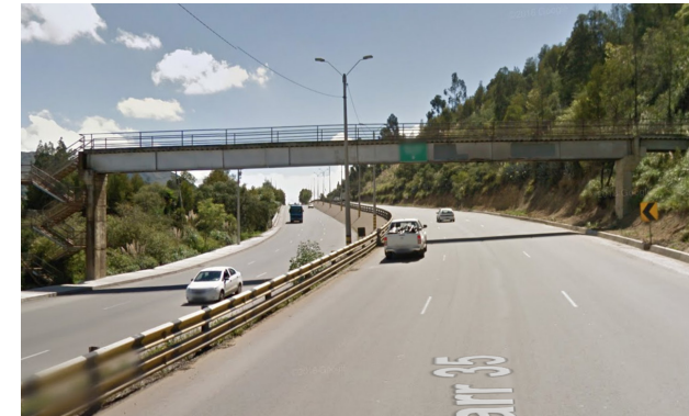
Fig 152. Paso peatonal elevado. Cortesía Google, 2015.
