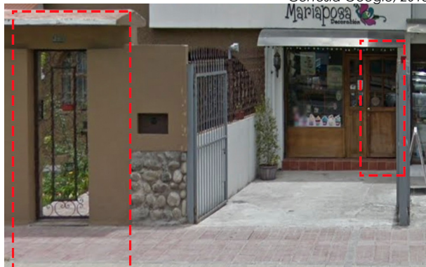
Fig 70. Puertas peatonales en edificación Cortesía Google, 2015.
