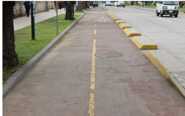
Fig 133. Ciclovía segregada. Cortesía Google, 2015.
