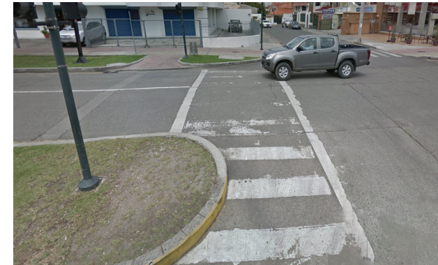
Fig 29. Rampa desplazada del cruce. Cortesía de Google, 2015.
