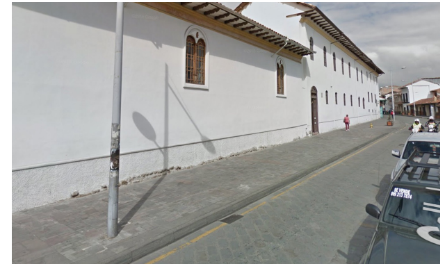
Fig 108. Acera sin buffer de seguridad. Cortesía Google, 2015.
