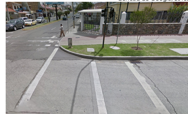
Fig 30. No existe rampa. Cortesía de Google, 2015.
