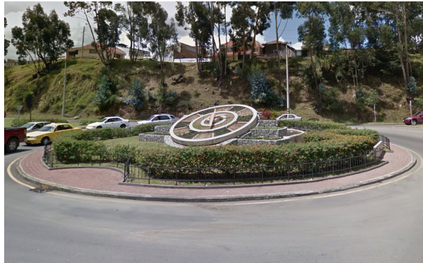
Fig 159. Mantenimiento general bueno. Cortesía Google, 2015.
