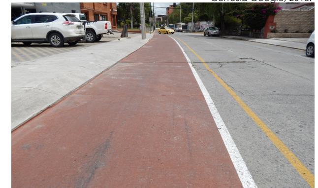
Fig 132. Ciclovía en la calzada. Cortesía Google, 2015.
