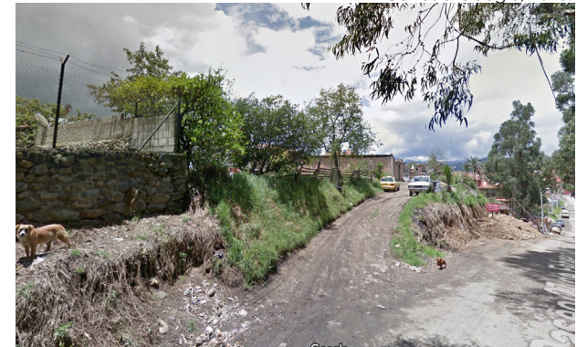
Fig 162. Mantenimiento general muy malo. Cortesía Google, 2015.
