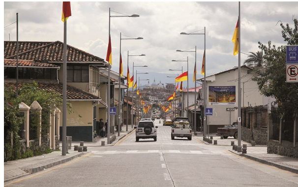
Fig 117. Luminarias en la Av. Loja, Cuenca - Ecuador. Recuperado de: https://goo.gl/NvYohn
