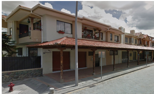
Fig 76. Edificación estado bueno. Cortesía Google, 2015.
