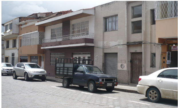
Fig 35. Edificación adosada a dos lados. Autores, 2018.
