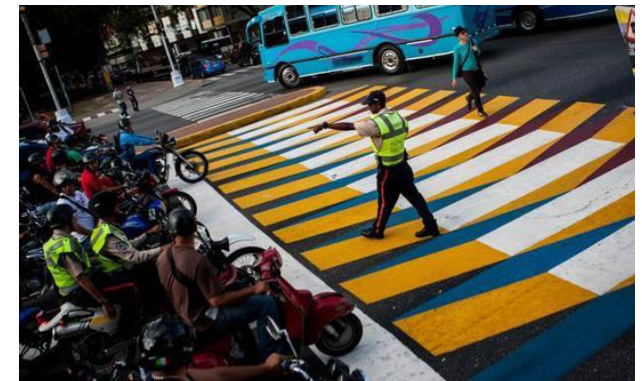
Fig 23. Paso peatonal con bandas de alta visibilidad. Recuperado de: https://goo.gl/2dHokN
