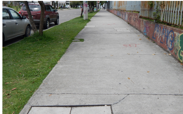
Fig 103. Acera en buen estado. Autores, 2018.
