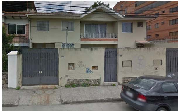
Fig 77. Edificación estado regular. Cortesía Google, 2015.
