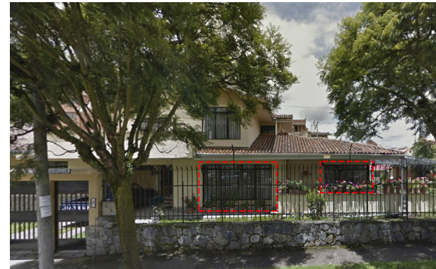
Fig 74. Ventanas en edificación con cerramiento. Cortesía Google, 2015
