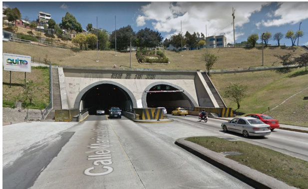
Fig 7. Segmento túnel. Cortesía Google, 2015.
