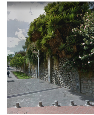
Fig 156. Muro de contención. Cortesía Google, 2015.
