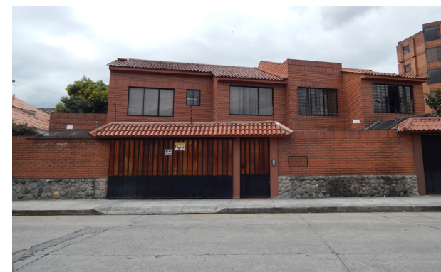
Fig 41. Vivienda multifamiliar. Cortesía Google, 2015.
