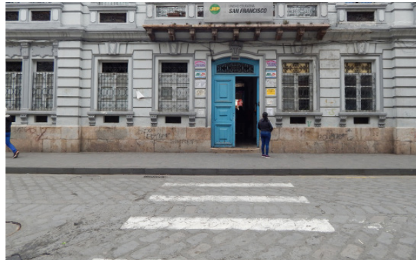
Fig 149. Cruce a mitad de segmento, Paso Cebra. Autores, 2018.
